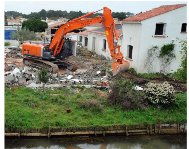
Démolition à la Faute-sur-Mer
